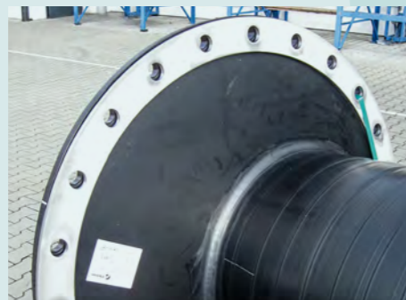
Gebäudeanbindung mit hinterlegtem Edelstahlflansch
