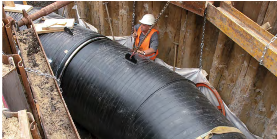
PKS®-Rohre kompensieren die äußeren Kräfteinwirkungen durch definierte Verformung
