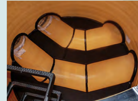
Kontrollschacht mit parallel laufendem abgewinkeltem Gerinne
