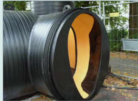
Übergang auf Eiprofil mit eingeschweißter Voute aus PE-Platten und mit zugfester Wandeinbindung
