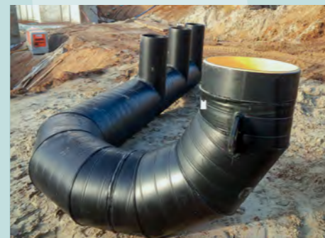
Vorgefertigter Segmentbogen und Verteilerstrang für Lüftung
