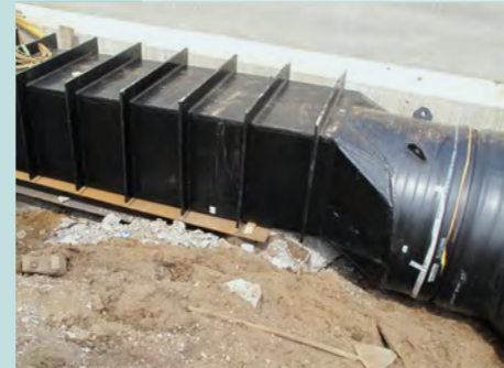
Übergang PKS ® -Rohr kreisrund auf Rechteckkanal inkl. Verstärkung
