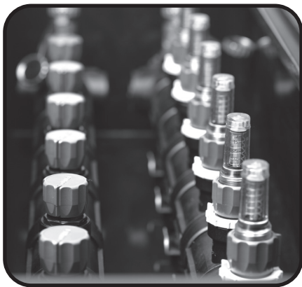
Verteilerschacht Typ WM mit Durchflussmesser
