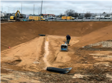
Regenrückhaltebecken mit FRANK BVR 9000 HP als stabile Schutzlage auf Kunststoffdichtungsbahn.
