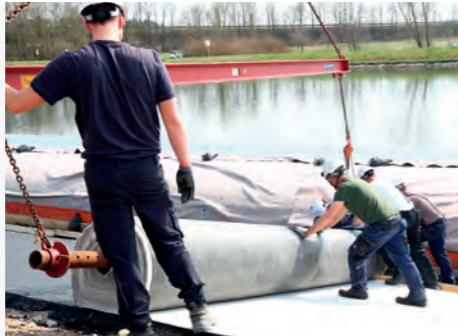
Kanaldammsanierung mit "BVR 9000 HP plus" und integriertem Durchwurzelungsschutz.
