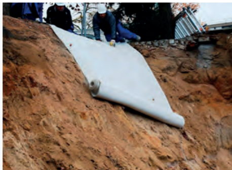
Sicherung einer Baugrubenwand mit BVR 9000 HP. Erosionssicherung bzw. Rieselschutz des Arbeitsraumes.
