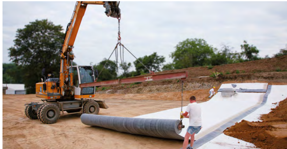
Verlegung einer Bentonitmatte
