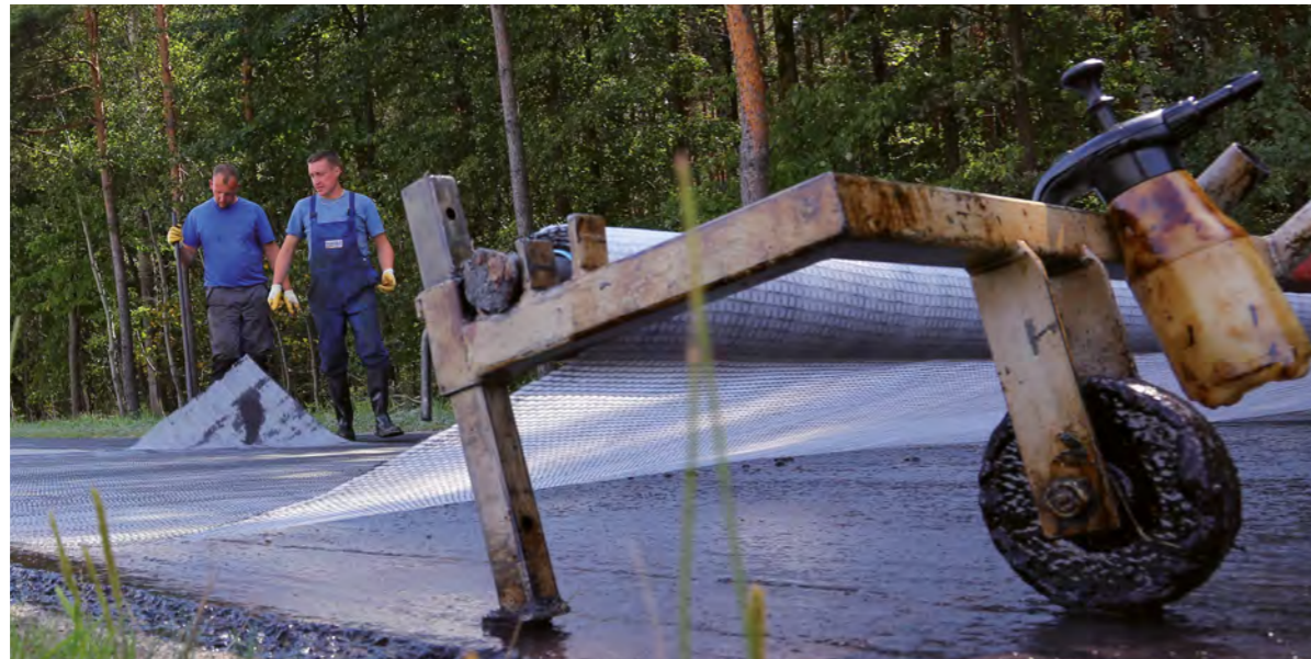
Verlegung auf gefräster Asphaltfahrbahn
