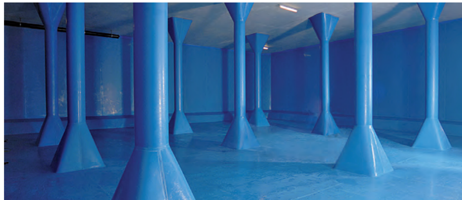
Vorher: Sanierungsbedürftiger gefliester Trinkwasserspeicher
