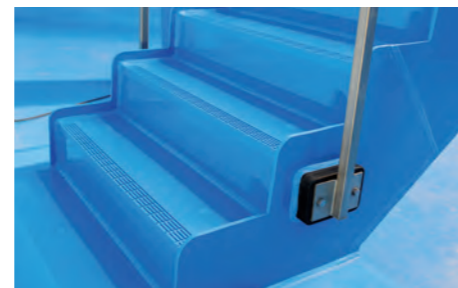
Auskleidung einer Betontreppe mit PE-Platten
