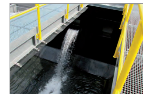
Beckenauskleidung mit Betonschutzplatten aus PE
