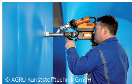
Komplexe Bauformen lassen sich einfach mit Betonschutzplatten auskleiden und schweißen © AGRU Kunststofftechnik GmbH
