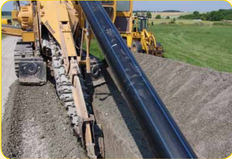
Sureline®-Rohr beim Einfräsen
