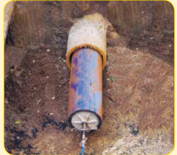
Sureline®-Rohr beim Relining
