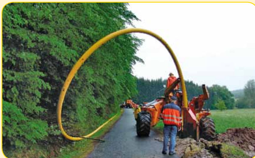
Sureline® Rohr beim Einpflügen
