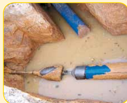
Horizontal-Spülbohrverfahren
